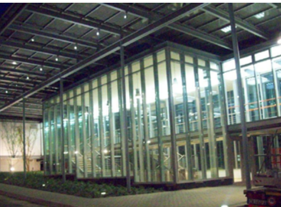
sopra, Particolare della passerella collegamento tra spina e fabbricato produttivo up, Detail of the footbridge between offices and productive building
