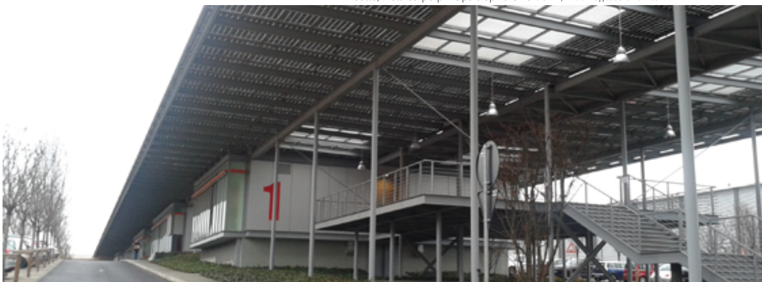
sotto, Vista corpo principale Spina Uffici down, Main offices overview
