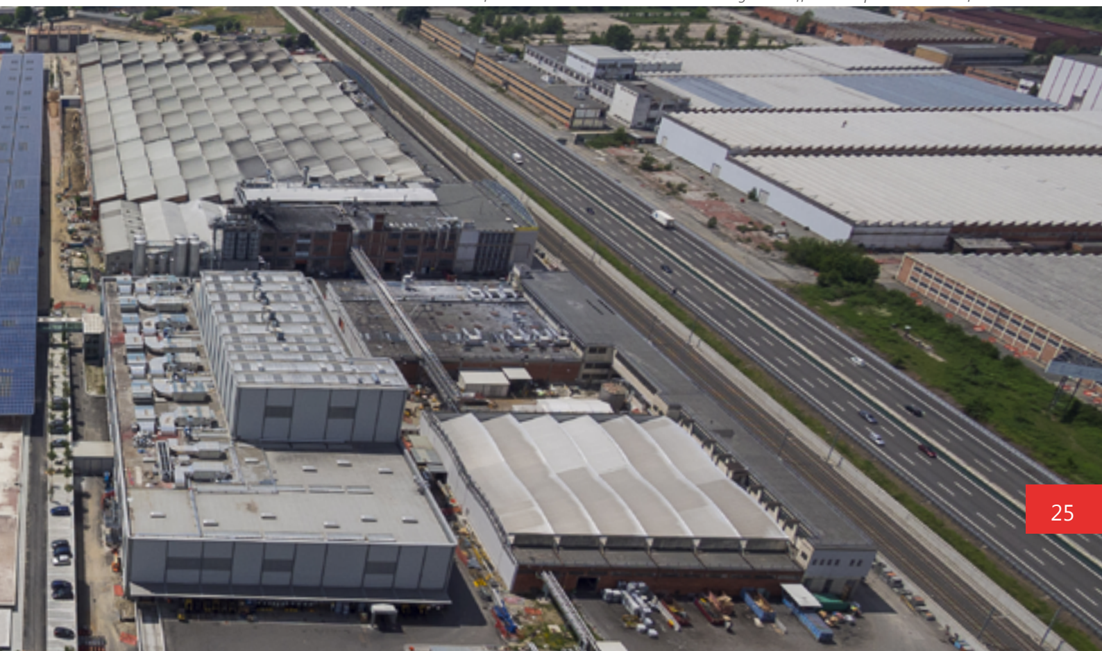
Visione di insieme dell'area realizzata: Capannoni Industriali e Spina Uffici con copertura fotovoltaica Overview of the constructed area: Industrial Buildings and Offices with photovoltaic roof
